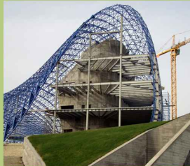
Giàn không gian kết hợp lõi bê tông cốt thép
