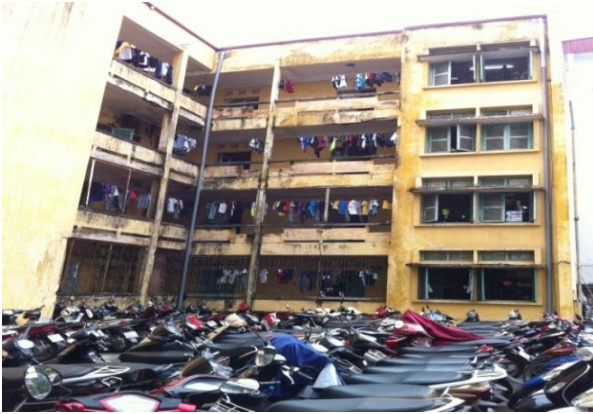
Hình 1. 18. KTX Trường ĐH Xây Dựng
