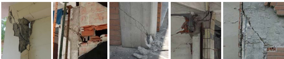
Hình 1.1. Một số hình ảnh phá hoại các cột và liên kết cột – dầm các nhà khung BTCT dưới tác động động đất [39],[79],[82],[95],[125]
