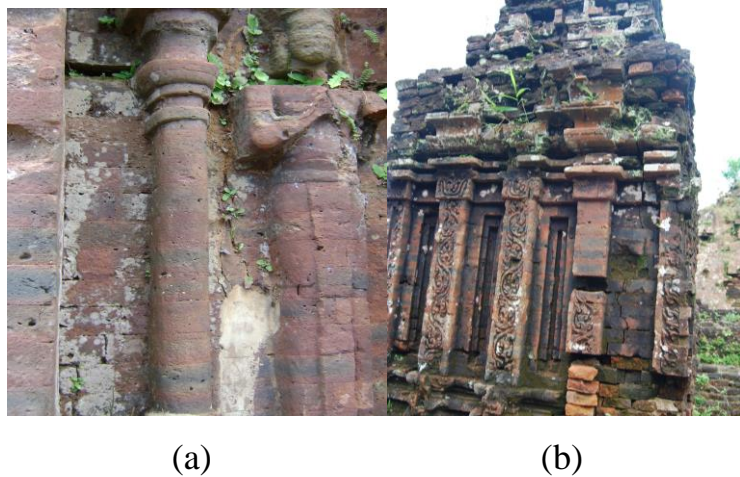
Hình 2.12. (a) - Các viên gạch đều nằm vừa vặn, sít sao trên Tường tháp Mỹ Sơn không có dấu hiệu của việc chặt gãy gạch để ráp cho vừa, một việc làm bắt buộc khi gạch đã nung chín và (b) - Dấu vết một mảng tường gạch đặc biệt tại Mỹ Sơn là sự sơ suất trong quá trình xây dựng hay mang một ý nghĩa đặc biệt nào đó khi chưa thực hiện điêu khắc, trang trí(!?)
