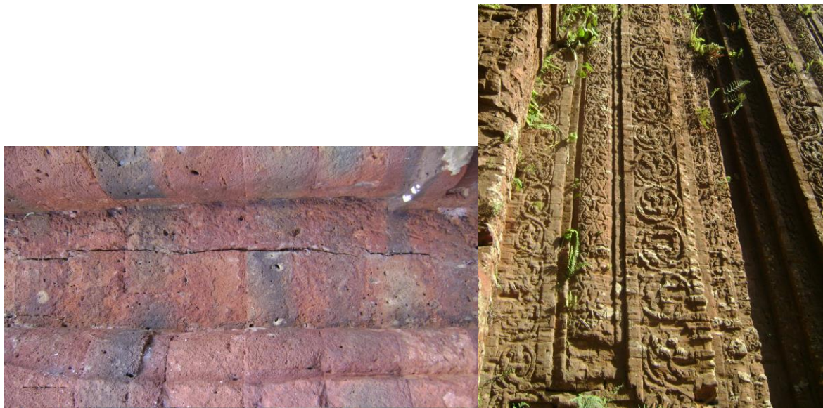
Hình 2.13. Những dấu tích trên bề mặt mà chúng ta thấy hoàn toàn không hiện diện các viên gạch bị chặt gãy nham nhở ở trên mặt tường-một việc làm bắt buộc phải có trong quá trình xây dựng - Ảnh trên Trụ trang trí bằng gạch tại Mỹ Sơn-Quảng Nam
