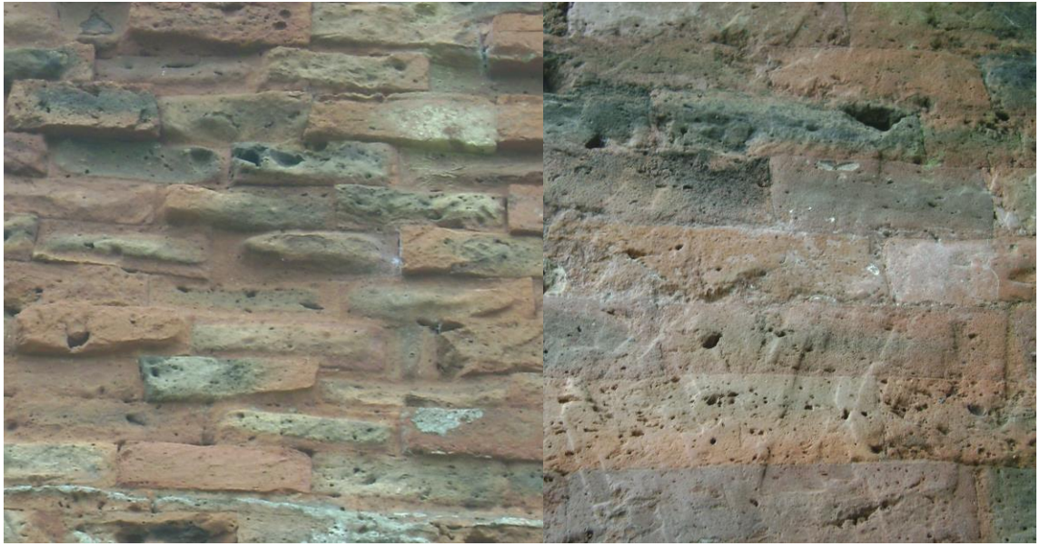
Hình 1.4. Một số hình ảnh cho thấy gạch trên Tháp tuy đã được xây thành một mảng tường không có mạch vữa và có dấu vết xoa quệt.
