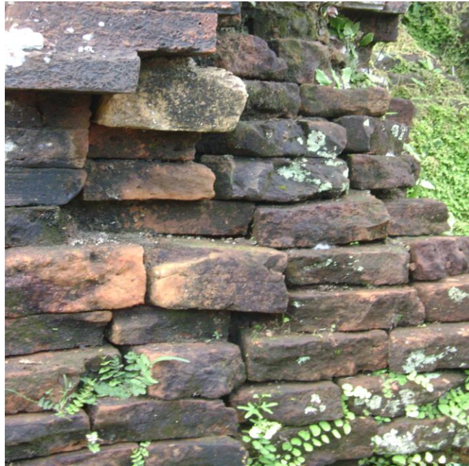
Hình 2.4. Gạch có tỷ trọng, độ hút nước, độ nung...khác nhau ở các lớp, các bề mặt (Mỹ Sơn)
