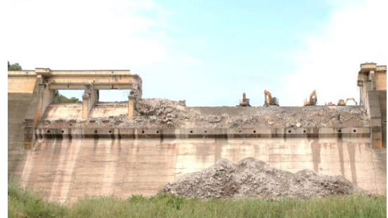
Nâng cấp đập tràn Hazelmere, Nam Phi (2012)
