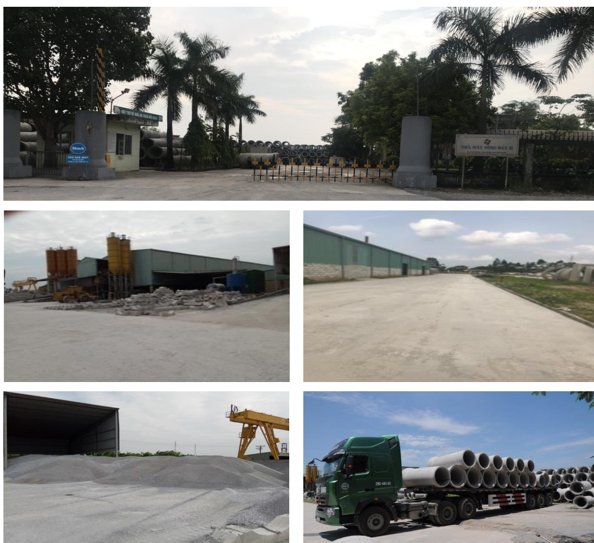
Hình 5.2. Nhà máy 2 – Công ty Cổ phần Vật liệu Xây dựng Sông Đáy
