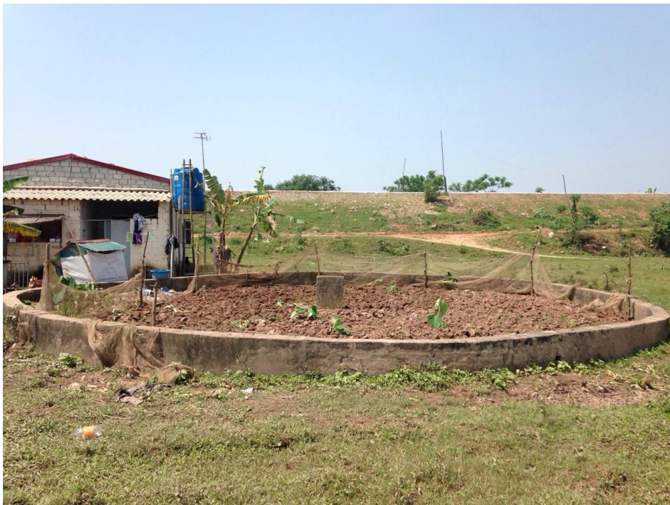
Hình 1-2: Giếng xử lý xói ngầm, mạch đùn mạch sủi tại hạ lưu đê Tả Hồng, đoạn qua Nghi Xuyên, Khoái Châu, Hưng Yên.
