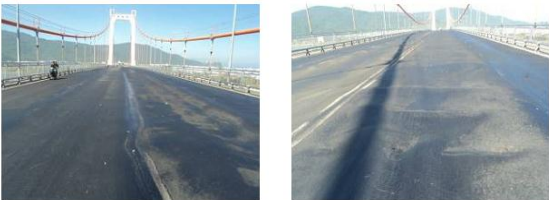
Hình 1-20. Các hư hỏng do hiện tượng xô dón bề mặt, mất sự liên kết với bản thép sau 4 năm khai thác [9].
