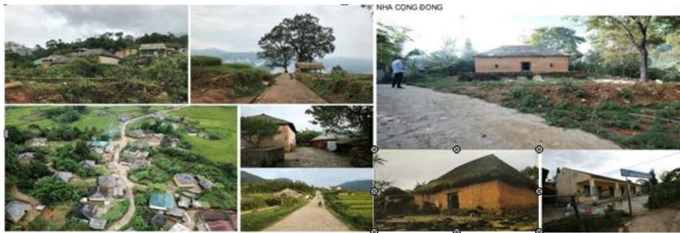
Hình 3. 5: Các công trình kiến trúc tại thôn Lao Chải, xã Y Tý. (Nguồn: [21])
