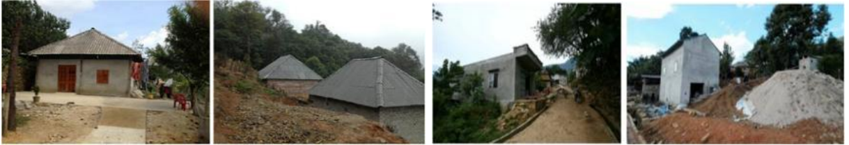
Hình 3. 6: Nhà trình tường đang bị xi măng hóa ở thôn Lao Chải
