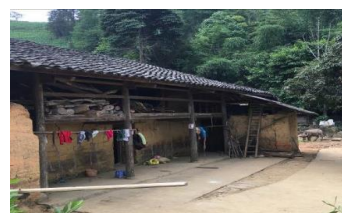
Hình 1. 16: Nhà trình tường xã Sín Chéng, Si Ma Cai.
