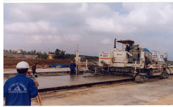
Hình 7. Máy rải bê tông liên hợp SP- 500 thực hiện công tác đầm và xoa hoàn thiện (ACC)
