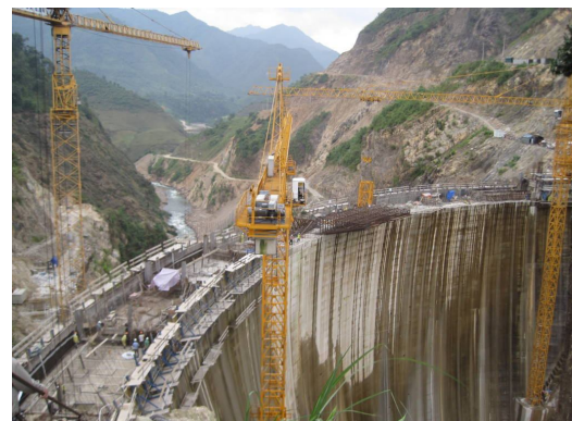
Hình 6. Thi công đập vòm cong 2 chiều Nậm Chiến
