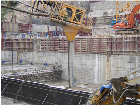
Hình 3. Đổ bê tông bằng băng tải tại đập CVC Sesan 3
