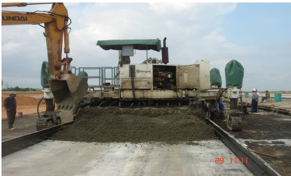
Hình 7. Máy rải bê tông liên hợp SP- 500 thực hiện công tác đầm và xoa hoàn thiện (ACC)
