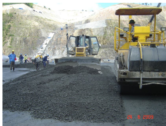
Hình 2. Thi công RCC đập thủy điện Đồng Nai 4 (Đắc Nông)
