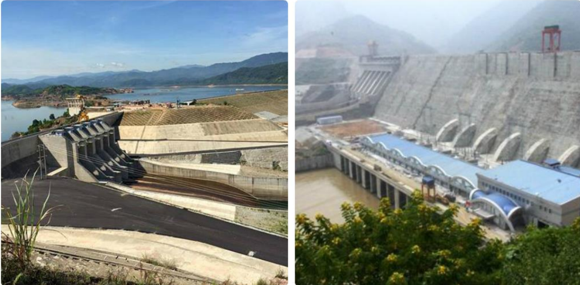
Hình 1-1: Hồ Tả Trạch và Thủy điện Sơn La (Nguồn: Internet)
