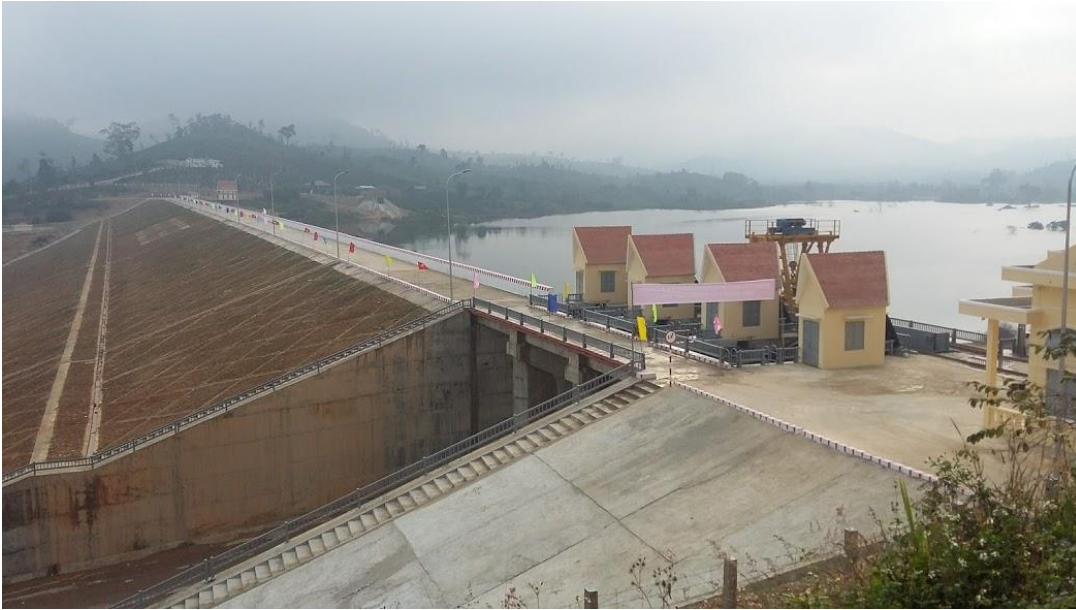
Hình 3-2: Hồ chứa nước Ea Rót, Đắk Lắk
