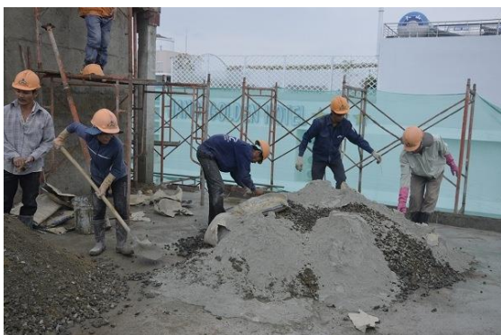
Hình 2.1 Trộn vữa bằng phương pháp thủ công
