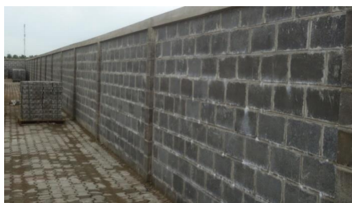
Hình 1.7: Thi công hoàn thiện tường gạch không nung
