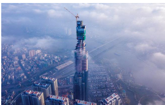
Hình 1.8: Công trình áp dụng công nghệ BIM toà nhà landmark 81 tầng
