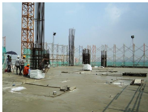
Hình 2.2 Hoàn thành thi công đổ bê tông sàn
