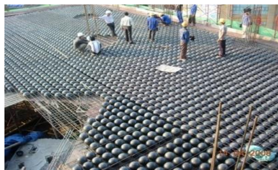
Hình 1.9: Thi công sàn BTCT bằng công nghệ sàn bóng Bubble Deck
