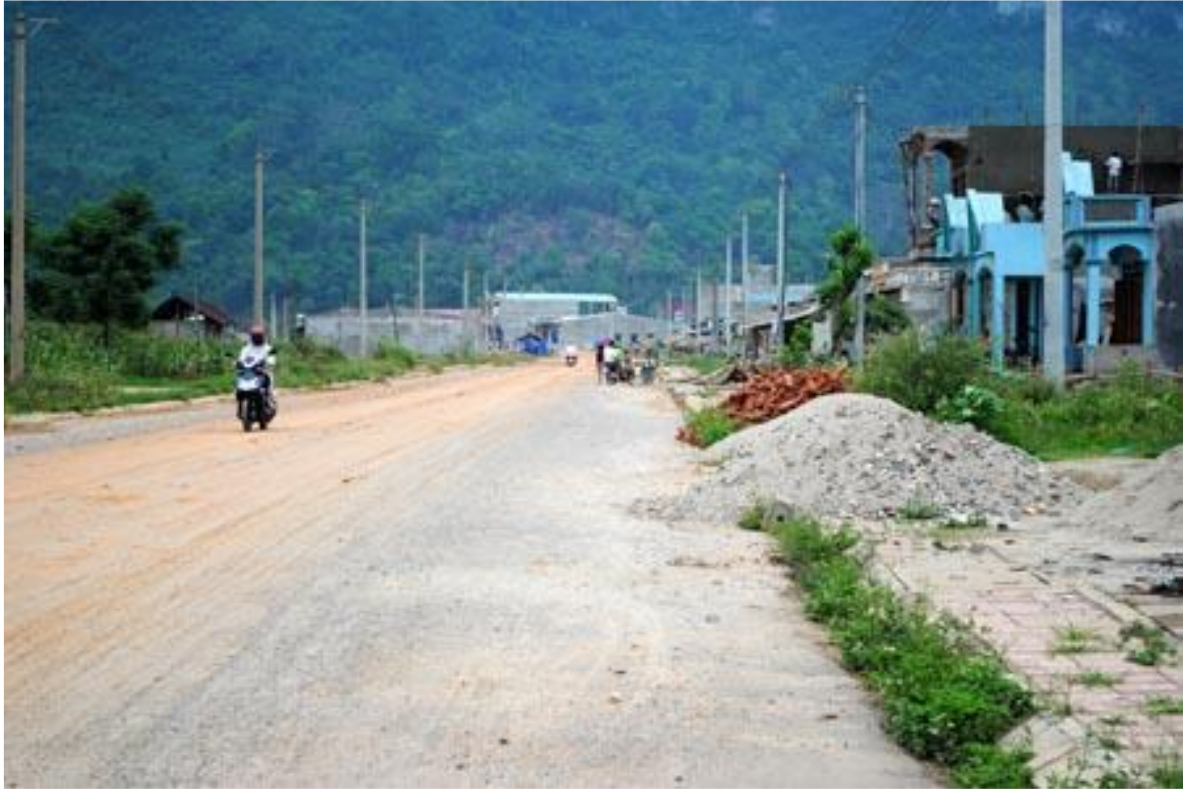
Hình 3: Dự án cải tạo cơ sở hạ tầng
