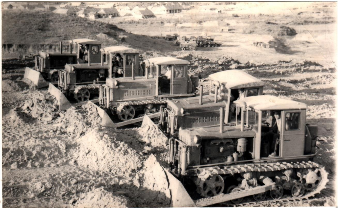
San ủi mặt bằng xây dựng nhà máy (Nguồn: Kỷ yếu 50 năm truyền thống Mỏ sắt Trại Cau)
