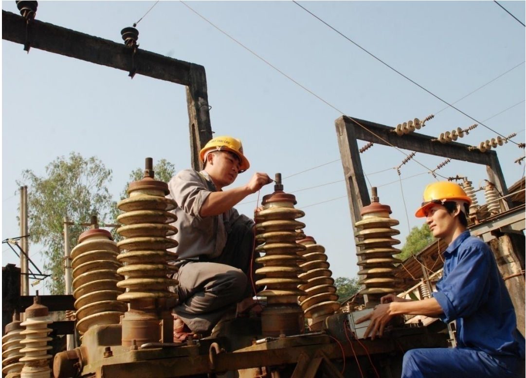
Công nhân Mỏ đang sửa chữa điện tại trạm biến thế 35 KV (Nguồn: Kỷ yếu 50 năm truyền thống Mỏ sắt Trại Cau)
