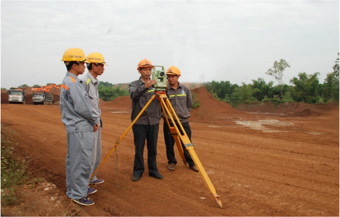
Tổ trắc địa đang khảo sát công trường (Nguồn: Kỷ yếu 50 năm truyền thống Mỏ sắt Trại Cau)
