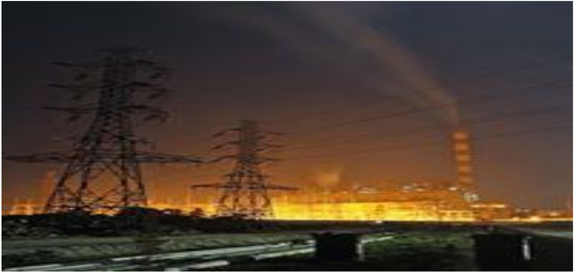
Một góc nhà máy Nhiệt Điện Hải Phòng trên địa bàn Thủy Nguyên
