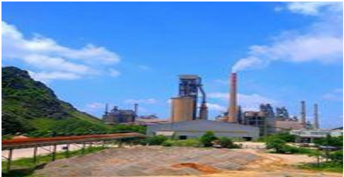
Nơi sản xuất của nhà máy xi măng Hải Phòng trên địa bàn Thủy Nguyên
